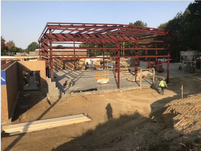
PEMB Gym Ongoing
